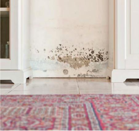
fall durch Feuchtigkeit gekommen, muss die Feuchtigkeitsquelle ermittelt werden. Häufige Ursachen sind mangelhafte Dämmung und Kondensatbildung durch Kältebrücken.
